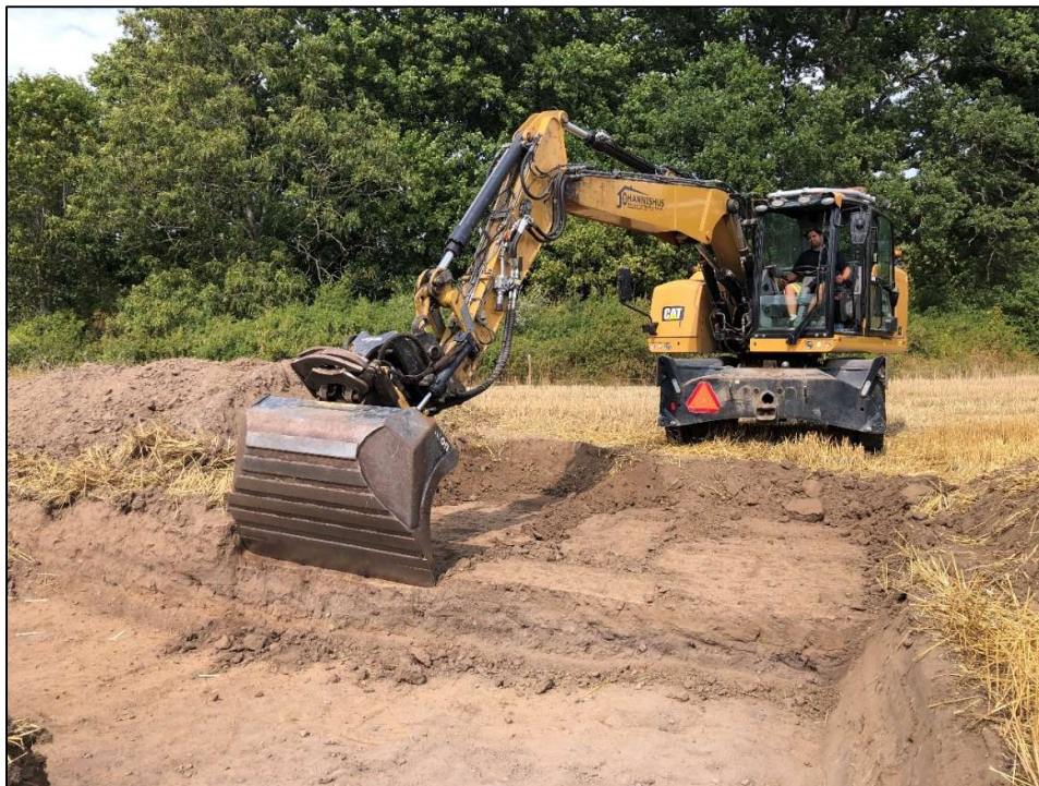
Fig.5 – Bortschaktning av matjord ned till kulturlagret. Vy mot N inom den redan nedschaktade provytan
